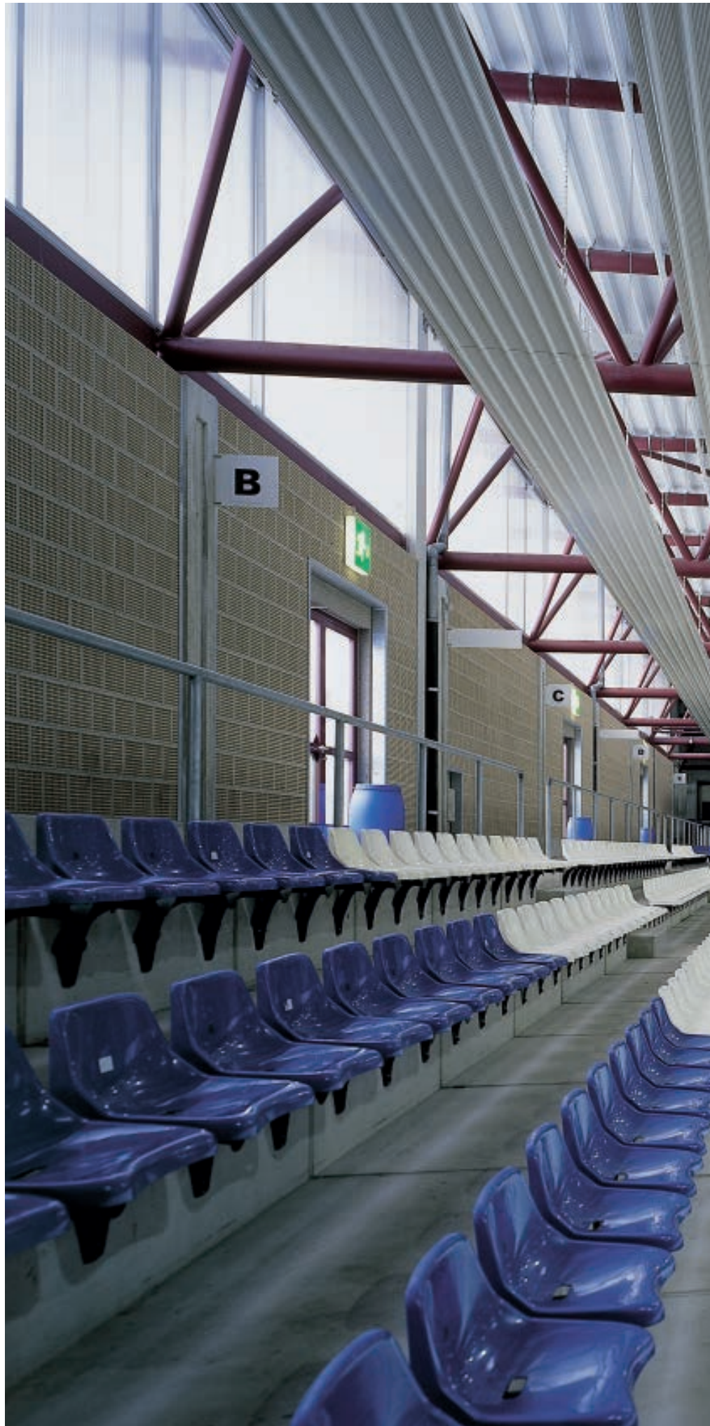
Pabellón de deportes sobre hielo de Küssnacht (CH)
