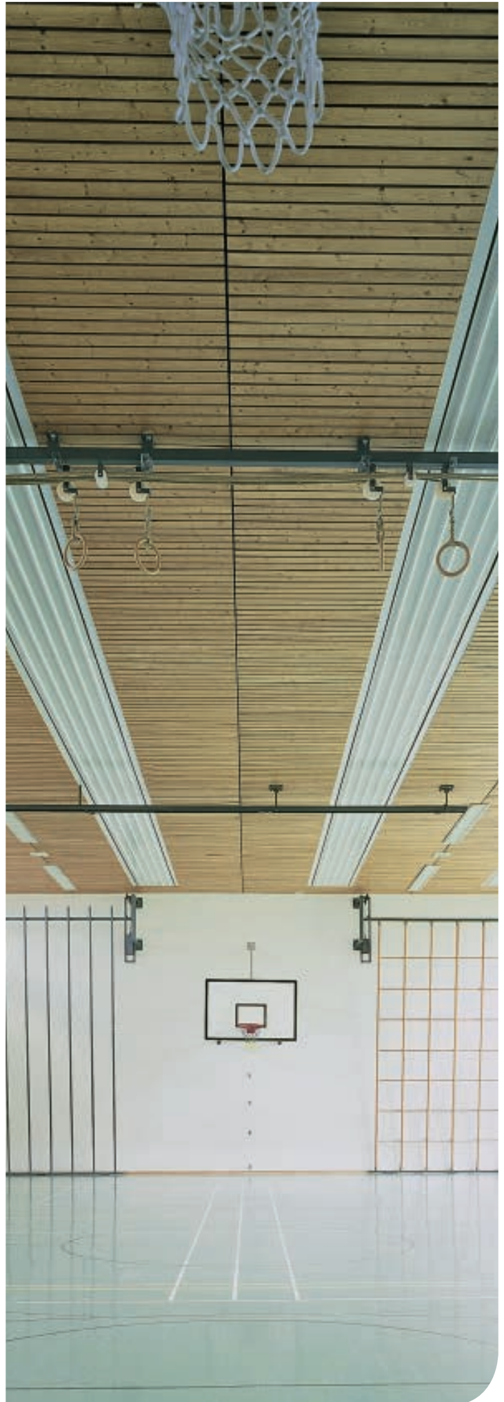
Pabellón polideportivo, Múnich (D)
